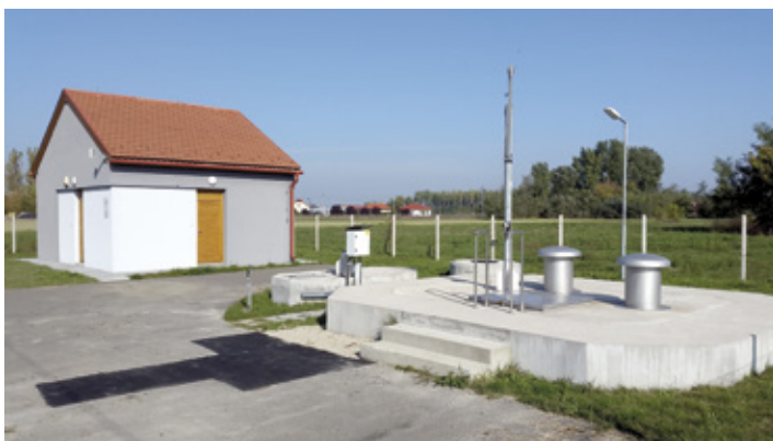
Legnagyobb beruházásunk, a szennyvízhálózat kiépítése volt
